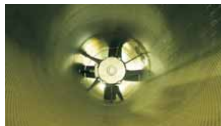
Система вытяжки воздуха 110 кВт
