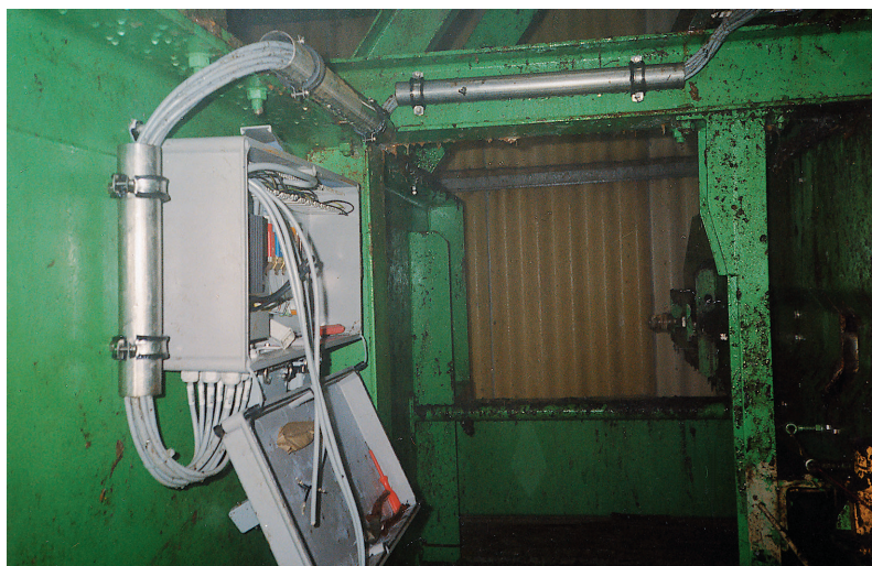
Прокладка кабеля в компостной установке
