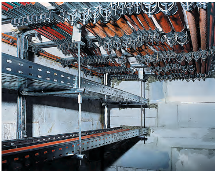
Перед тестом на пожаростойкость.
