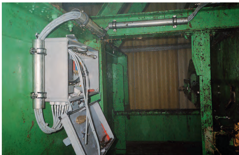
Прокладка кабеля в компостной установке
